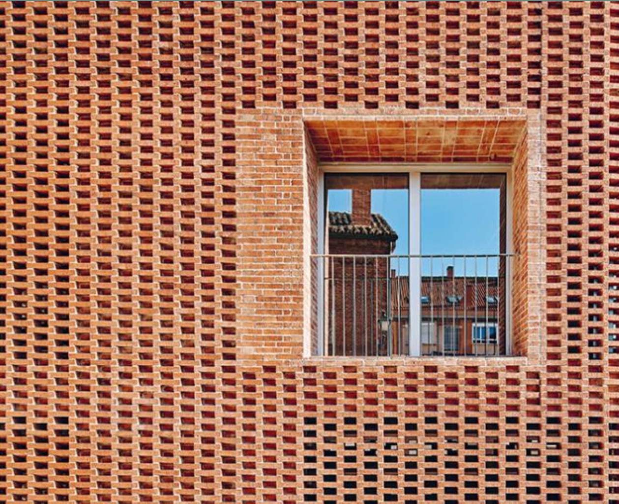
Biblioteca Municipal y Teatro, Boadilla del Monte (Madrid) Extudio, Matos Castillo Arquitectos y Toni Gelabert Arquitecte
